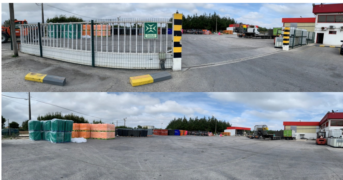
FIGURA 4.1. FOTOGRAFIAS DA ÁREA A INTERVENCIOR PARA AMPLIAÇÃO DO CAIS DE AVES VIVAS
